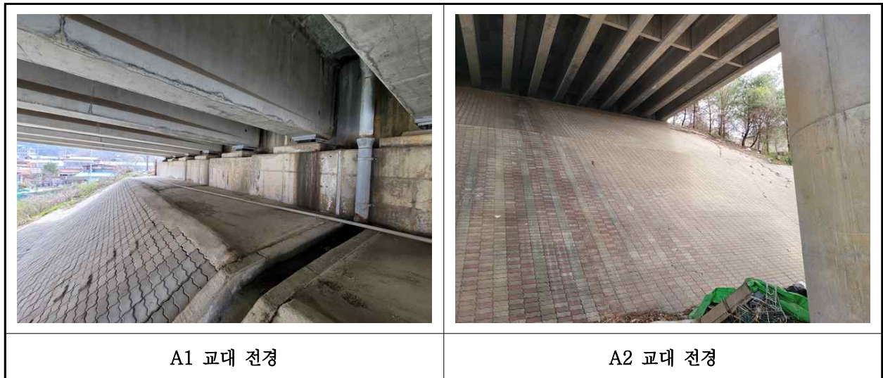
【사진 3.3.8】 교대 전경
