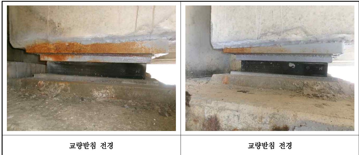
【사진 3.3.12】 교량받침 전경
