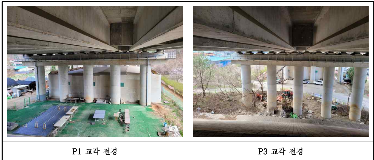
【사진 3.3.10】 교각 전경
