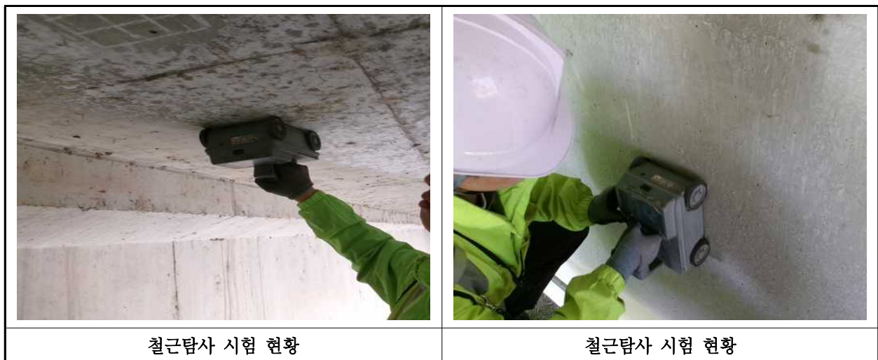
【사진 3.4.2】 철근탐사 시험
