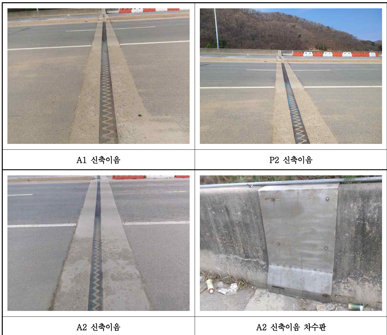
【사진 3.3.14】 신축이음장치 전경
