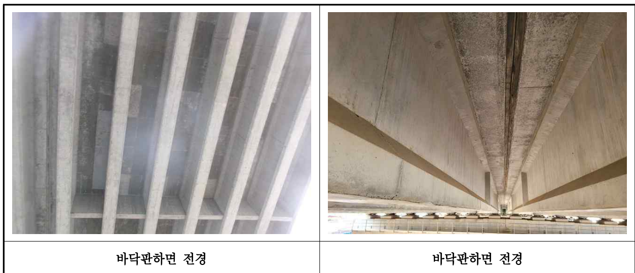
【사진 3.3.2】 바닥판하면 전경
