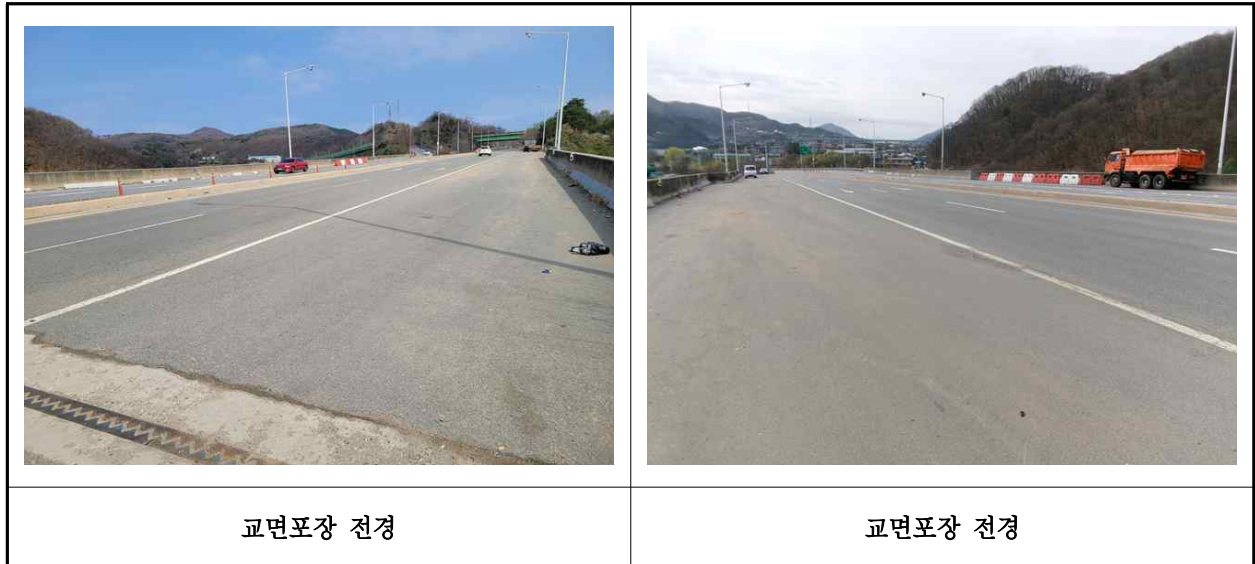
【사진 3.3.17】 교면포장 전경
