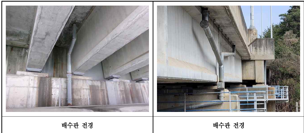
【사진 3.3.19】 배수시설 전경
