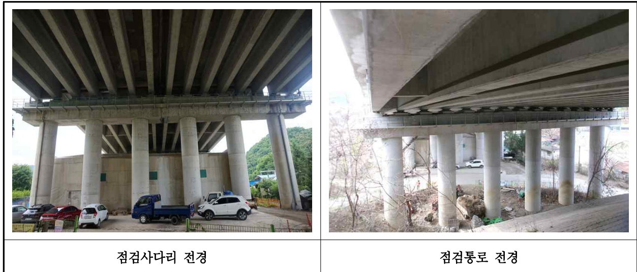
【사진 3.3.23】 교량 점검시설 전경
