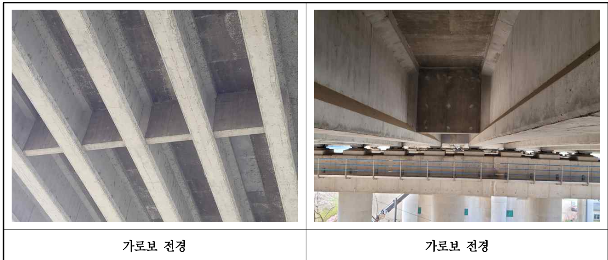
【사진 3.3.6】 가로보 전경
